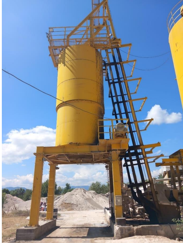
Слика II.17. Силос за складирање готов асфалт со дозатор за полнење камиони за транспорт на готов асфалт.
