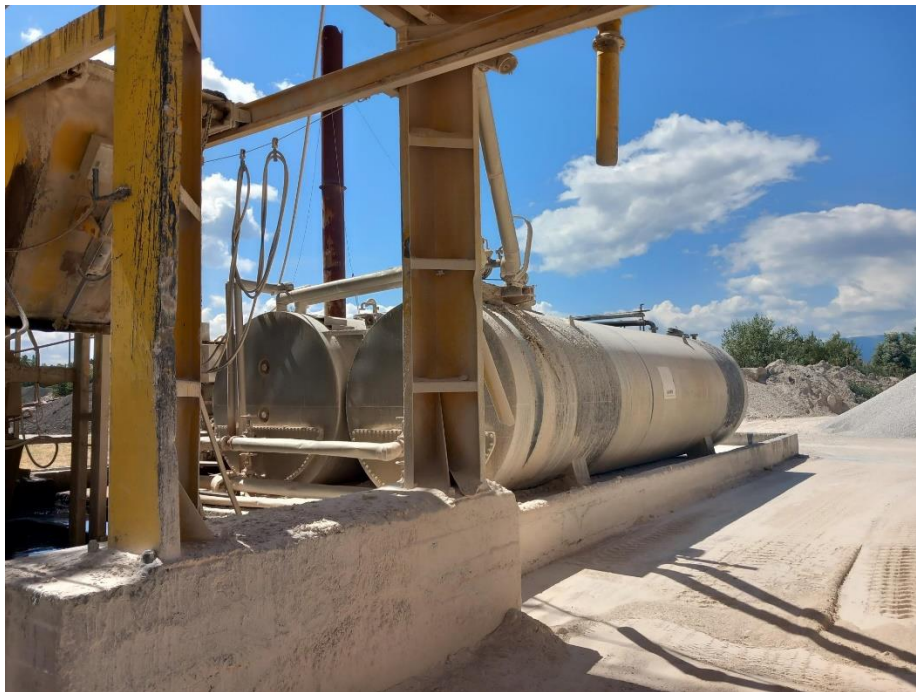
Слика II.9. Две хоризонтални термоцистерни со поединечен капацитет од по 30 t, наменети за складирање битумен во втечнета состојба.
