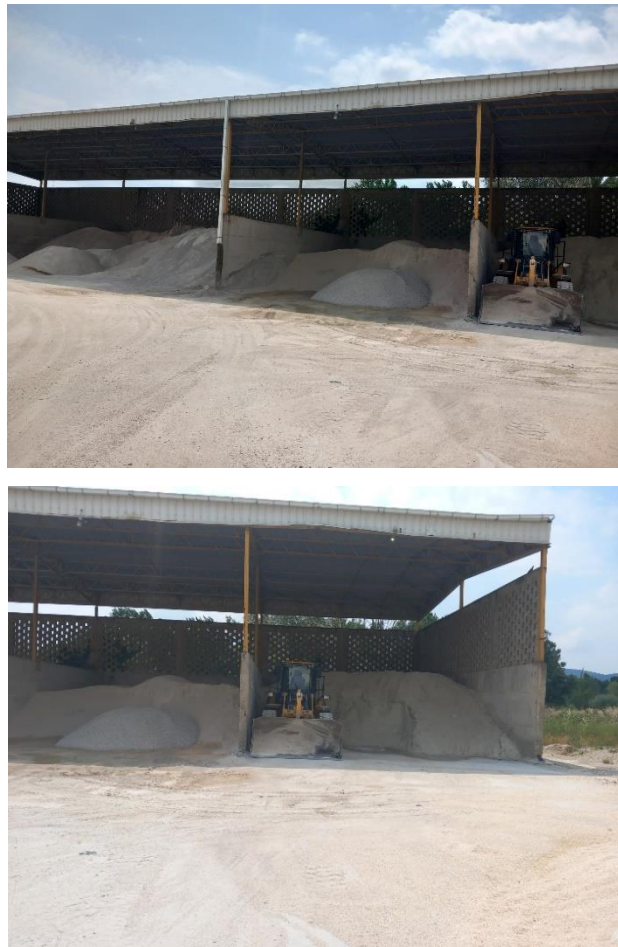
Слика 11. Покриено складиште за ризла-камен агрегат, поделен на повеќе бункери со вкупен капацитет за складирање камени фракции од 2700 t. Камените фракции се со димензии од 0-4, 4-8, 8-11, 8-16 и 16-22 mm.
