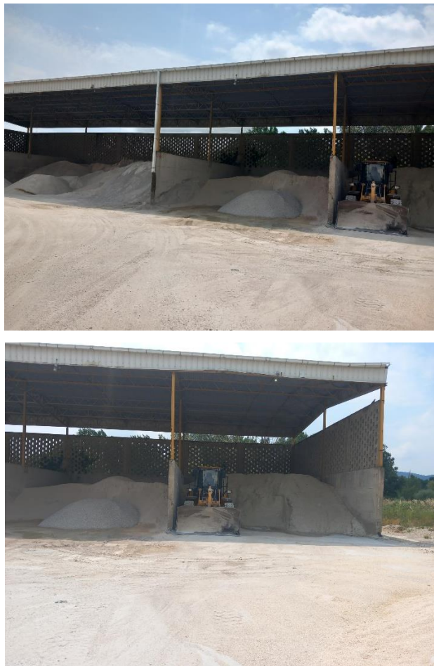
Слика II.11. Покриено складиште за ризла-камен агрегат, поделен на повеќе бункери со вкупен капацитет за складирање камени фракции од 2700 t. Камените фракции се со димензии од 0-4, 4-8, 8-11, 8-16 и 16-22 mm.
