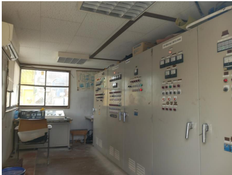
Слика II.6. Командна кабина за управување со асфалтната база.
